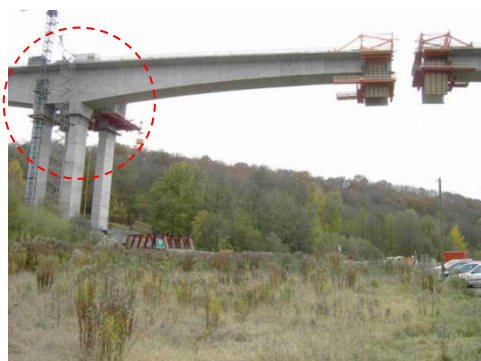
Fig. 8.13.05: vínculo de tercera especie : dos modos de simbolizarlo y un caso práctico de "viga en voladizo"
