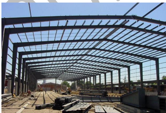
Fig. 8.09.01- CUERPOS VINCULADOS: Pórticos de una nave industrial (foto) y un posible modelo plano para resolverlos, formado por dos chapas
