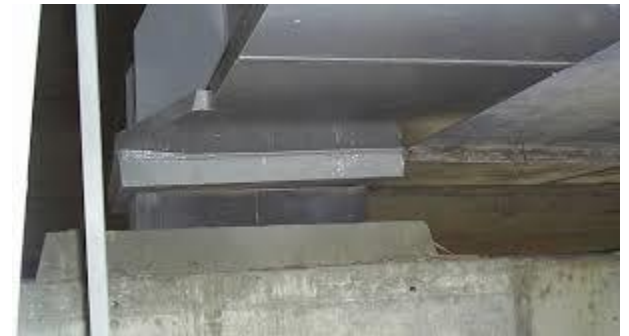
Apoyo de neopreno bajo viga metálica de un puente.
