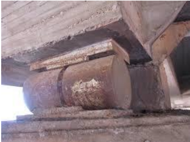
Apoyo de rodillos en puente de hormigón armado.
