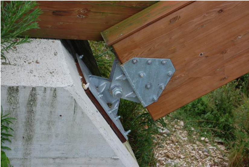
Vínculo fijo en una estructura de madera.
