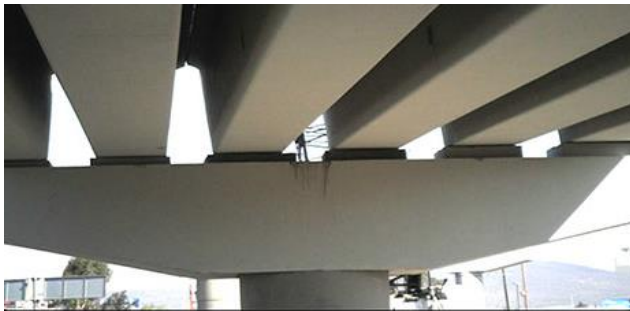
Apoyos de neopreno bajo vigas de una viaducto de hormigón pretensado / armado.
